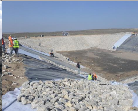
Johr Al Dik landfill (During)
