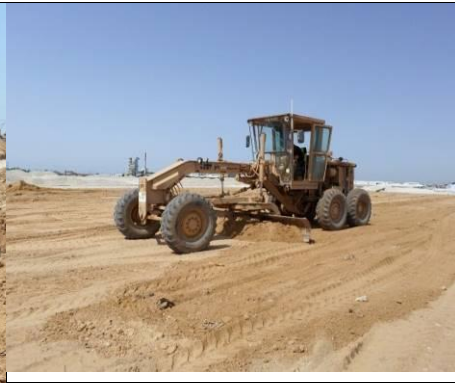
Preparation for Geomembrane and PE
